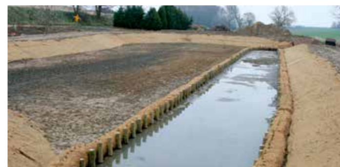
Les fascines coco ont été livrées munies de réservations afin de pouvoir y insérer rapidement des mottes de plantes.
