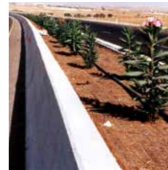
Autoroute à Chypre : économies d'arrosage et réduction de travaux d'entretien d'où une réduction des risques d'accidents de travail
