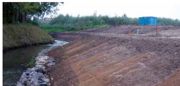
Utilisation d'une natte renforcée GREENFIX de type 400S
