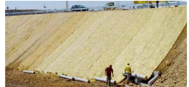
Protection d'un talus autoroutier avec Covamat plus à Lisbonne, au Portugal
