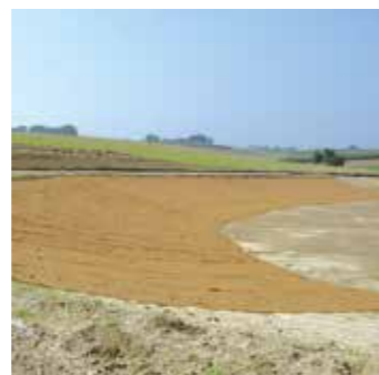
Mise en place d'une natte Eromat GREENFIX pour un bassin de retenue
