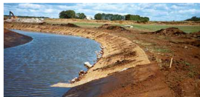
Utilisation de Covamat plus avec des filets biodégradables
