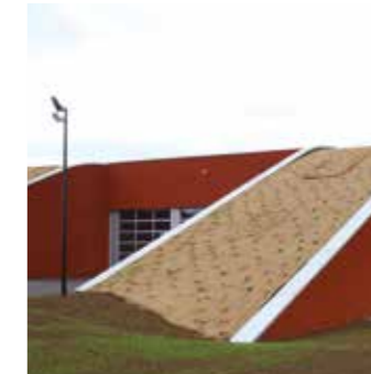
Toiture-jardin : les solutions recourant aux nattes Mulchmat ne nécessitent aucun entretien supplémentaire
