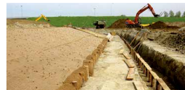
Solution écologique faisant appel à la natte Covamat fresh et à des fascines coco .
