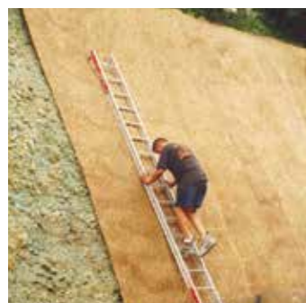
Installation d'une natte Rockmat GREENFIX type 5D sur une pente à 65°
