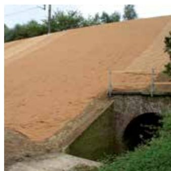
Protection d'un talus ferroviaire pentu avec la natte Eromat GREENFIX
