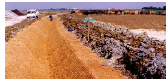
Protection d'un fil d'eau sur le bas-côté d'une route avec Covamat plus
