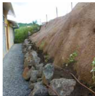
Installation réussie d'une natte Rockmat GREENFIX de type 6D en Nouvelle-Calédonie
