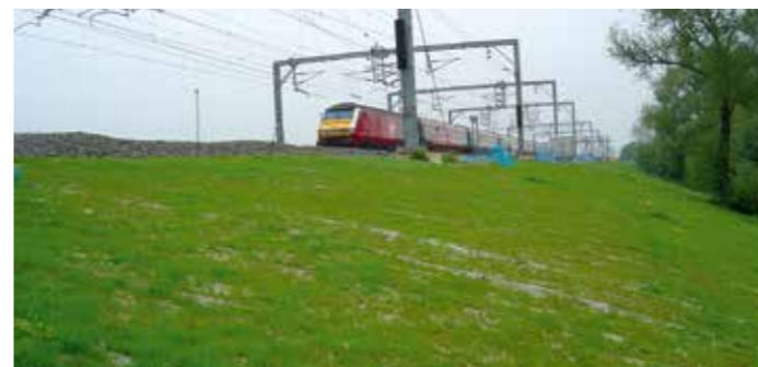
Implantation de végétation et protection contre les nuisibles au moyen de la natte Rockmat f³ de GREENFIX
