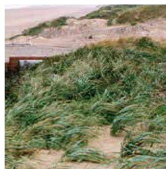
Plants d'oyat repiqués à travers une natte Eromat GREENFIX pour stabiliser une dune de sable.
