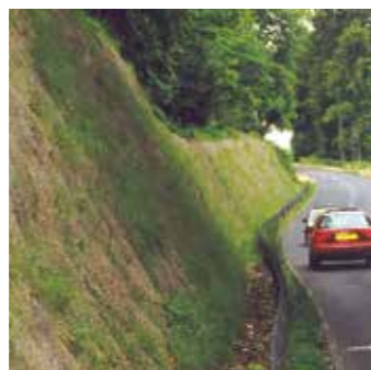
Talus protégé contre l'érosion après six semaines
